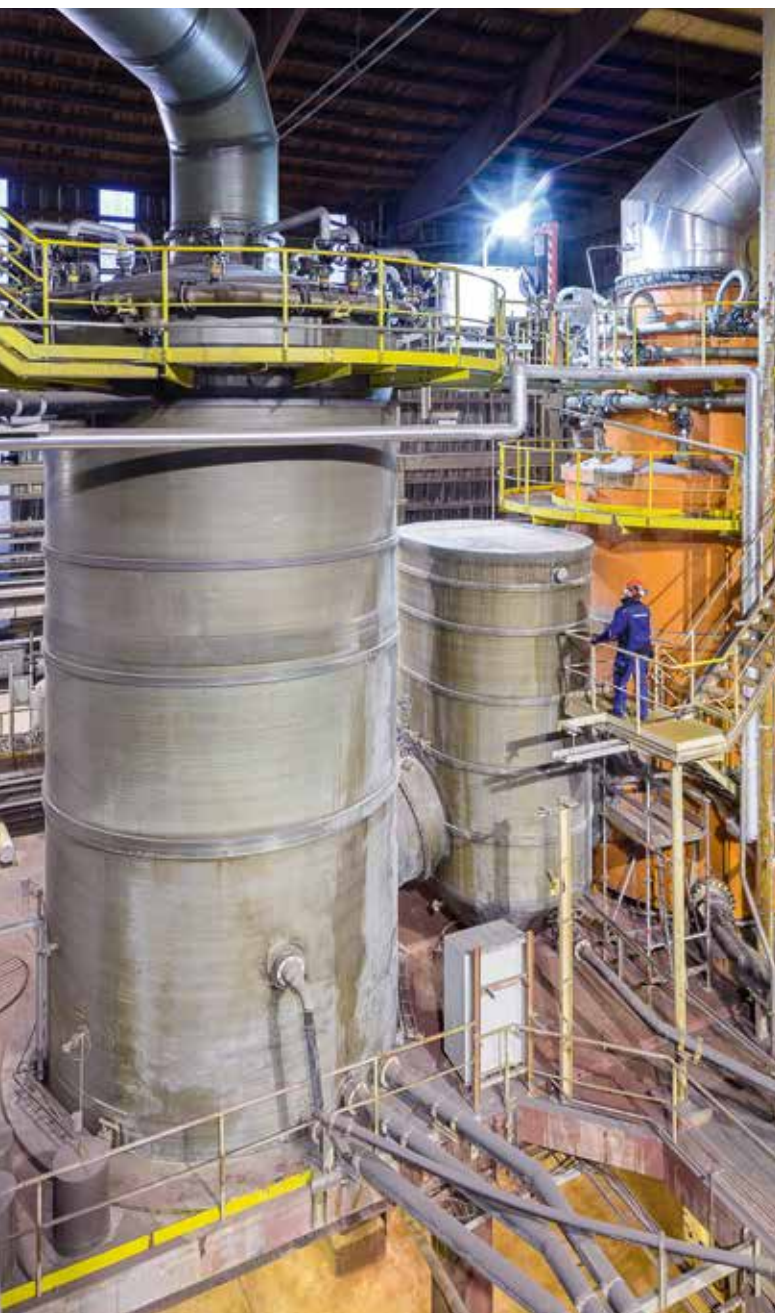
Für den weltweit tätigen Düngemittelhersteller YARA modernisierte HUGO PETERSEN die Gasreinigungsanlage der Schwefelsäureanlage am Produktionsstandort Siilinjärvi in Finnland.
